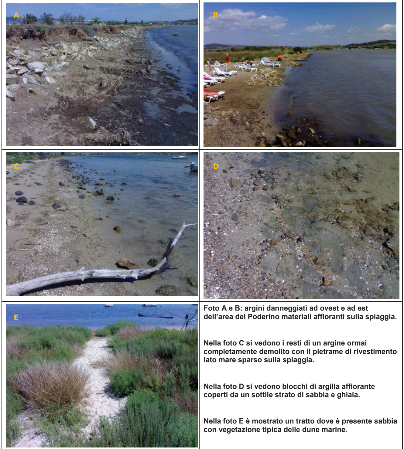
Figura 1 Immagini dell'argine a mare
